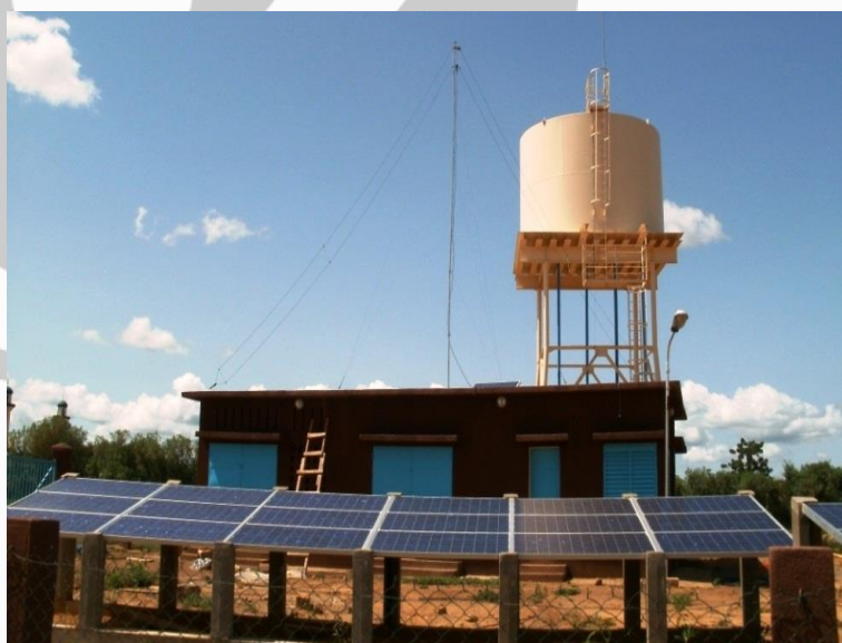
Le projet incluait l'installation de 24 pompes solaires au Mali
