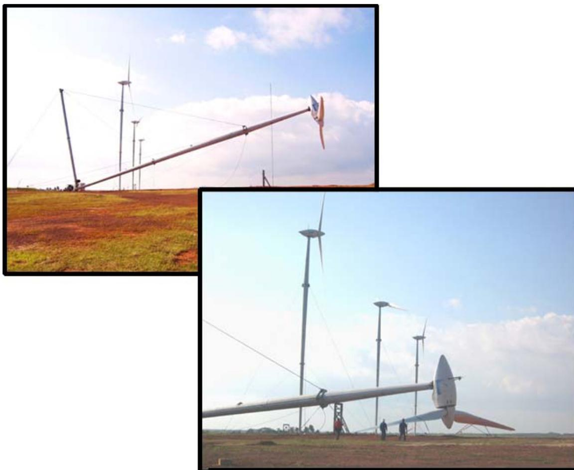
**Manœuvre de basculement d'une éolienne**
