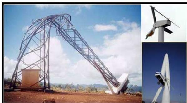
**Dégâts causés sur des éoliennes conventionnelles**
