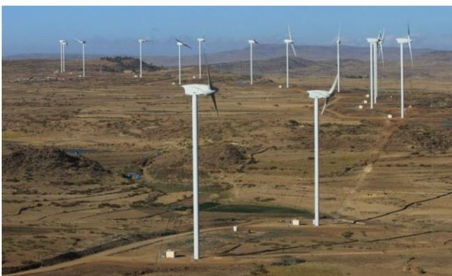
contractualisé avec Alstom Wind, la sous-traitance de la fourniture et l'installation de 54 éoliennes ECO 74 de classe 2 pour équiper les deux dernières phases.
